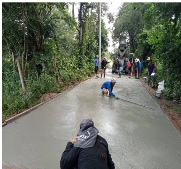
การก่อสร้างถนนคอนกรีตเสริมเหล็ก
